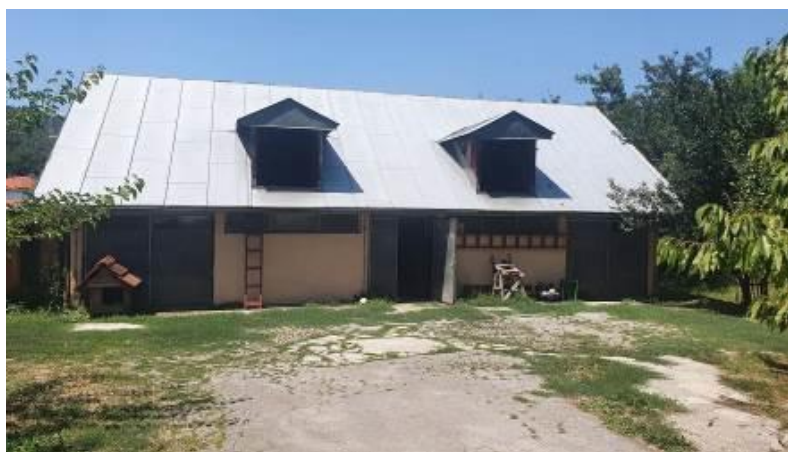
Slika 2 - Bespravno izgrađena štala
